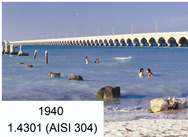
Progreso pier (Mexico)
